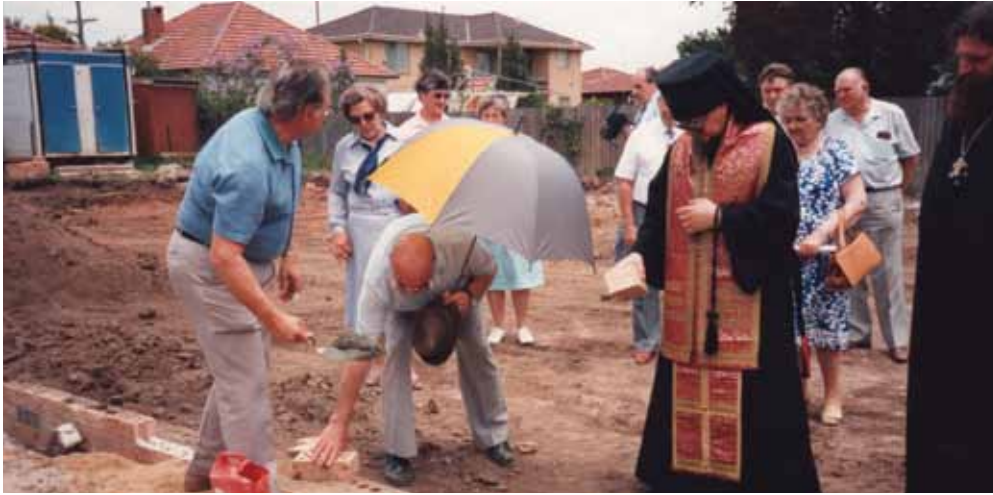
Закладка фундамента будущего отделения деменции (1986 год)
