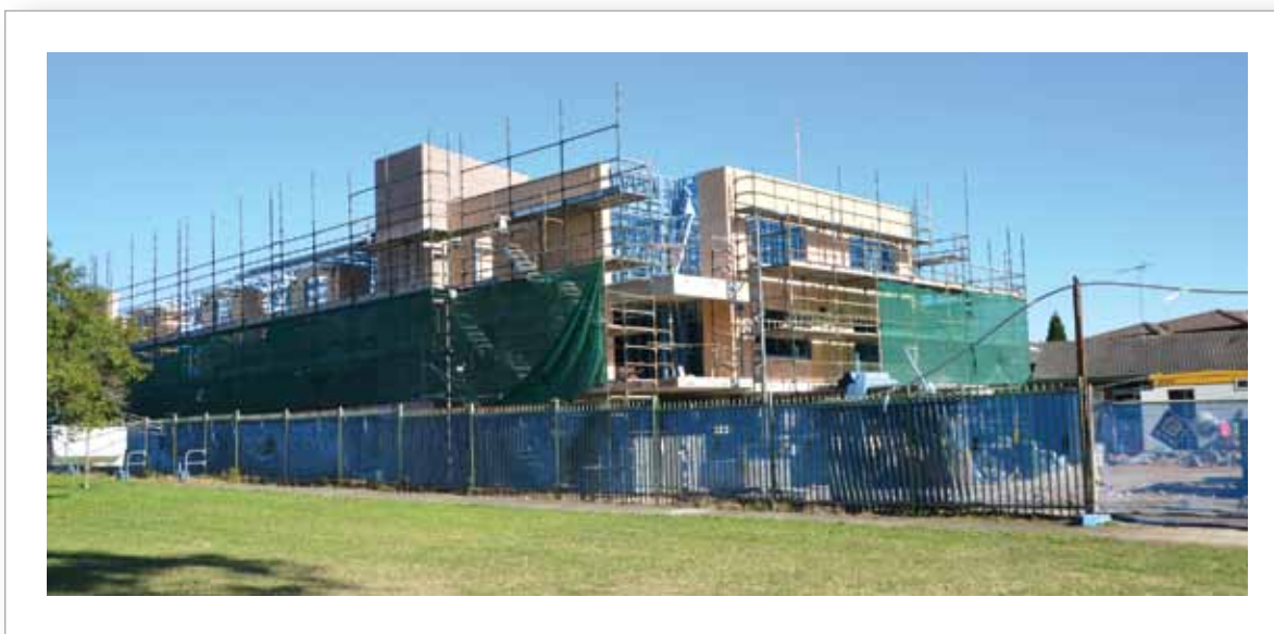
Строительство нового здания
